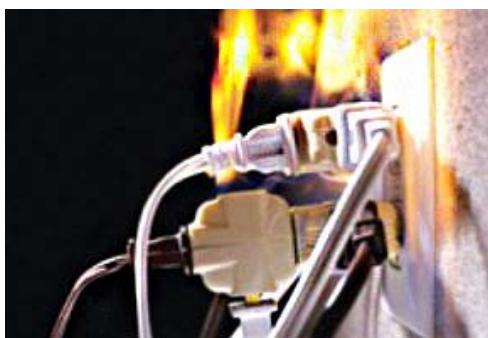
ภาพที่ ๘ แสดงภาพการเกิดไฟฟ้าลัดวงจร
